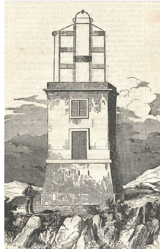
Línea Madrid-Cádiz, terminada hasta Aranjuez en 1847 y continuada probablemente en 1849.
